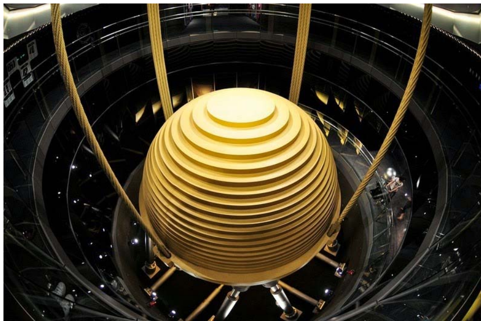
Σχήμα 2.24. Ο αποσβεστήρας ανέμου στο κτίριο Taipei 101 (“The 728-Ton Tuned Mass Damper of Taipei 101 | Amusing Planet,” n.d.).
