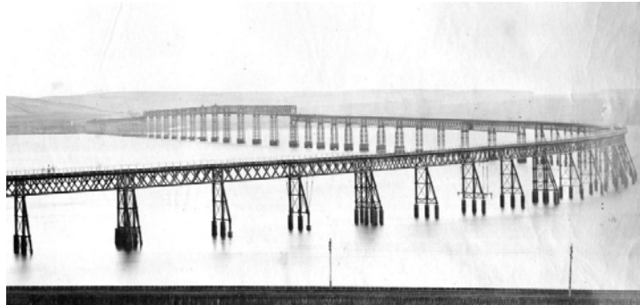
Σχήμα 2.20. Η αρχική γέφυρα Τάου πριν την κατάρρευση (“Wikipedia, the free encyclopedia,” 2015).
