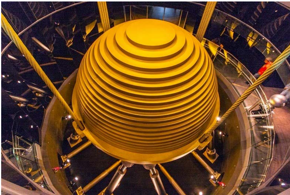
Σχήμα 2.23. Ο αποσβεστήρας ανέμου στο κτίριο Taipei 101 (“The 728-Ton Tuned Mass Damper of Taipei 101 | Amusing Planet,” n.d.).
