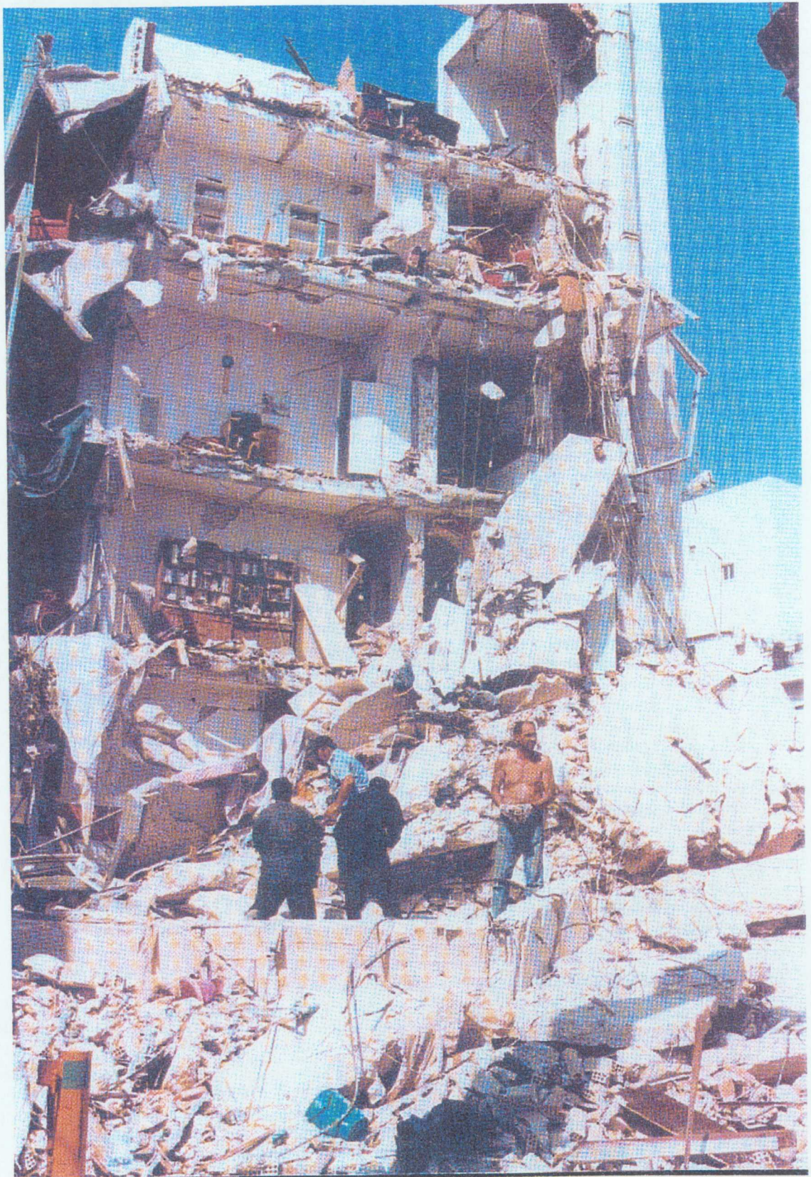
Φωτο 7-15: Η κατάρρευση της πολυκατοικίας στην Οδό Παπανδρέου στην Μεταμόρφωση.
