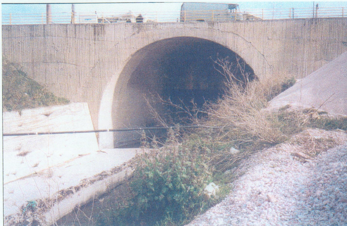
Φωτο 3-10: Τμήμα του Ποδονίφτη που είναι διευθετημένο.
