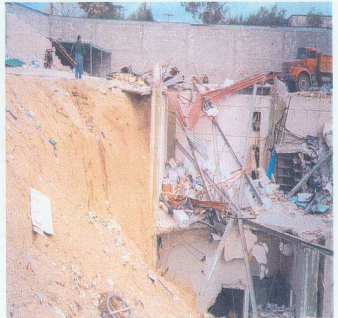
Φωτο 7-7,7-8: Από τα απομεινάρια του εργοστασίου γίνεται εμφανές το βάθος της εκσκαφής θεμελίωσης επάνω στην πλαγιά του ρέματος.
