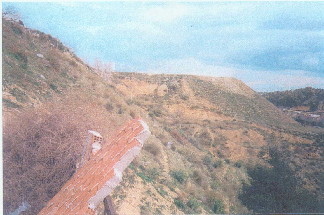
Φωτο 7-2: Το απότομο πρανές σε όρυγμα του οποίου χτίστηκε το εργοστάσιο της RICOMEX.
