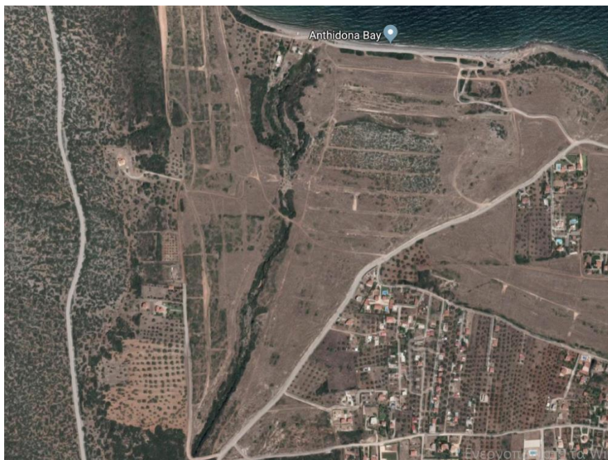
Εικόνα 2.5: Περιοχή κατάντη της εξόδου της σήραγγας Ανθηδώνας, στην οποία διακρίνεται η προσαγωγός διώρυγα και η θέση εκβολής της στον ομώνυμο όρμο (χάρτης Google).
