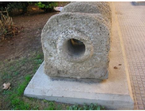
Πέτρα αγκύρωσης του μολύβδινου αγωγού υπό πίεση
