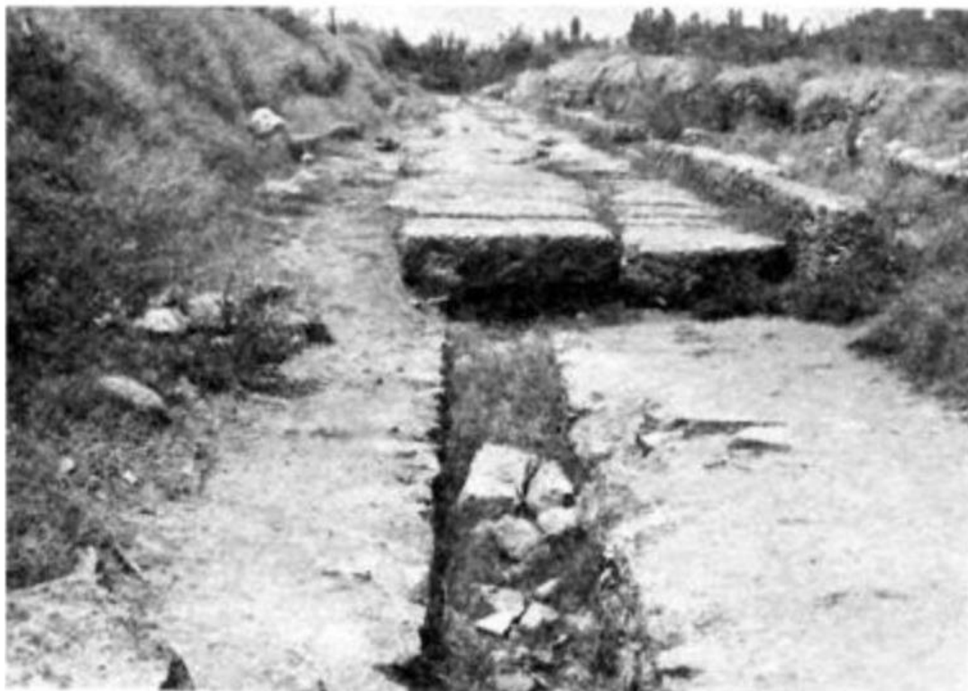
Εικόνα 26. Φωτογραφία του κεντρικού δρόμου με τον αγωγό αποχέτευσης. Πηγή: Καραδέδος, 1985, σελ.40
