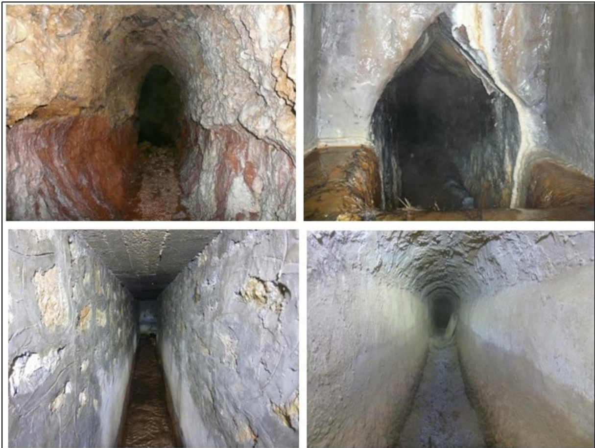
Εικόνα 5. 2 Διάφορες διατομές κατά μήκος του Αδριάνειου Υδραγωγείου
