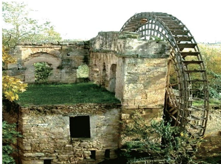
Εικόνα 2. 9 Νερόμυλος τοποθετημένος σε Qanat για την παραγωγή ενέργειας (Taghavi-Jeloudar, et al., 2013)
