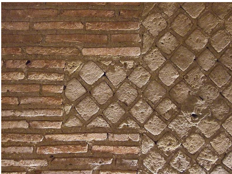
Εικόνα 3.3 Ρωμαϊκή τοιχοποιία μορφής opus mixtum, στο Θέατρο της Νάπολης. Από τα δεξιά της τοιχοποιίας είναι η τεχνική opus reticulatum και από τα αριστερά, η opus latericium Πηγή: (Wikipedia, 2008)
