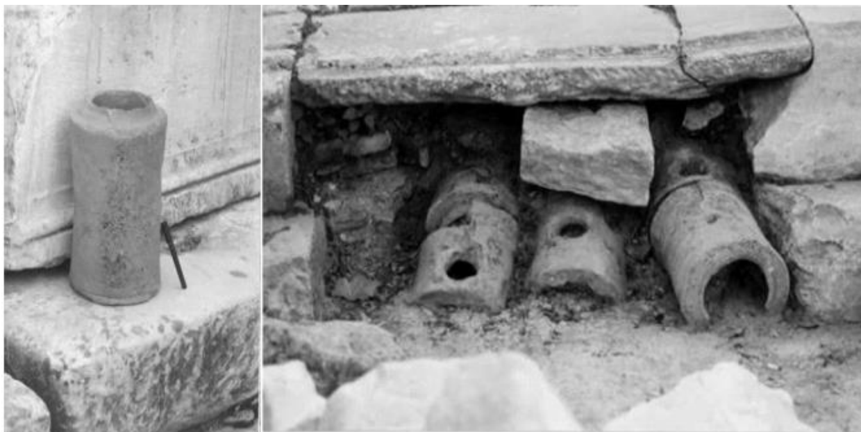
Εικόνα 2.2 Σωλήνες από πηλό στην Έφεσο, Ιωνία Πηγή: (Mays et al., 2007a).
