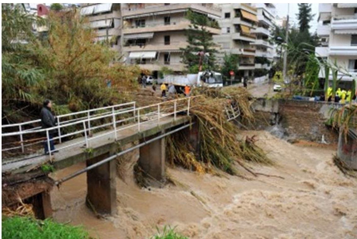
Φωτογραφία 4.3 Πεζογέφυρα Κορούζη - Μετά την υπερχείλιση
