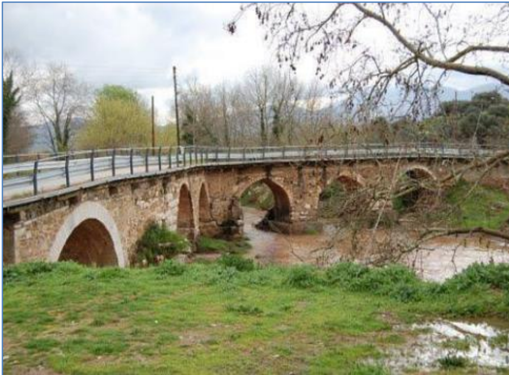
Εικόνα 1. Γέφυρα της Μαυροζούμενας
