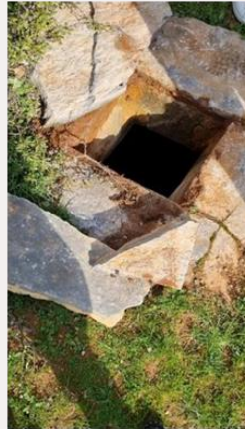
Στέρνα στο Πλάτωμα στην Λαγκάδα (½)
