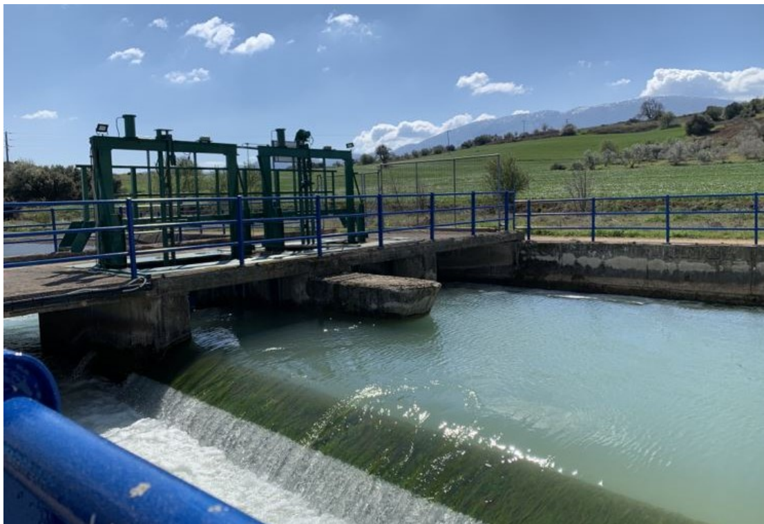
Εικόνα 2.6: Όψη ρυθμιστή Λ9, με πλευρική υπερχειλίση.
