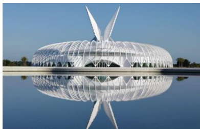
Κτίριο Καινοτομίας, Επιστήμης και Τεχνολογίας στο Πολυτεχνείο της Φλόριντα
