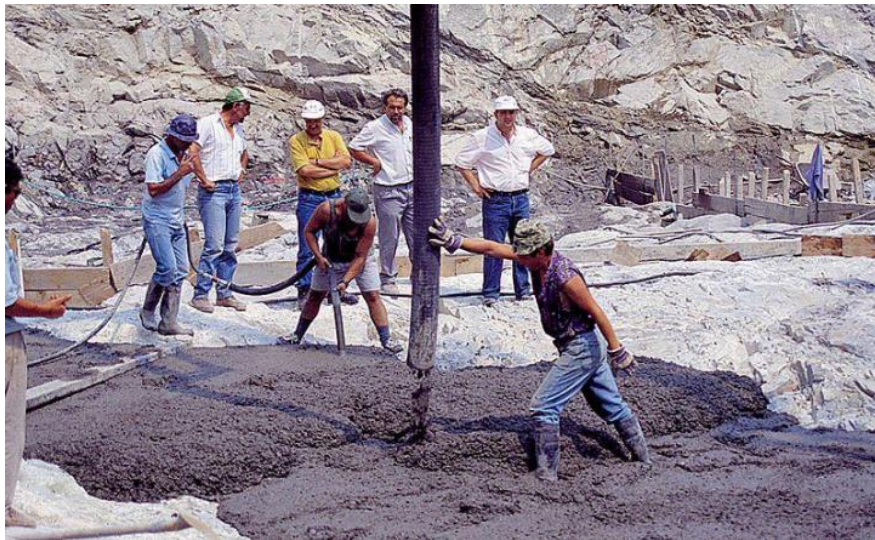
Σκυροδέτηση στρώσης θεμελίωσης
