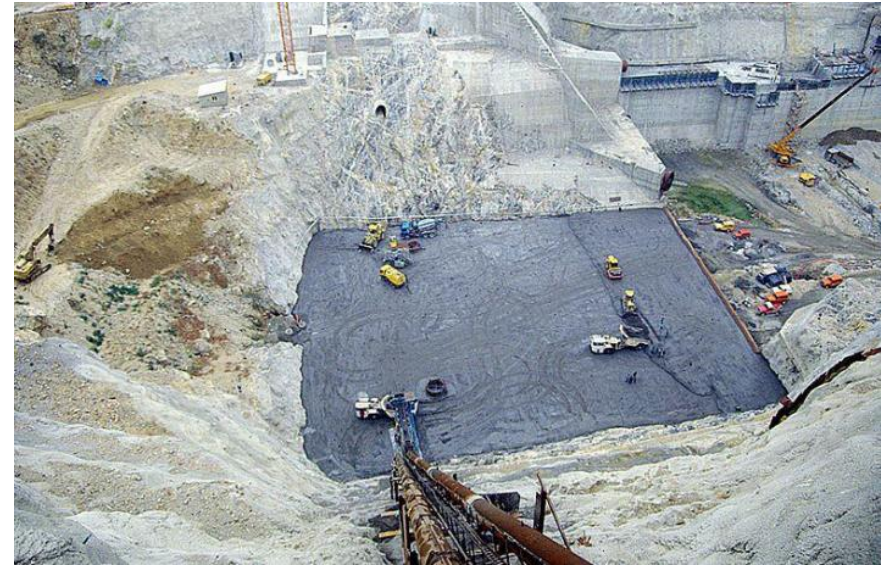
Κατασκευή στρώσης RCC
