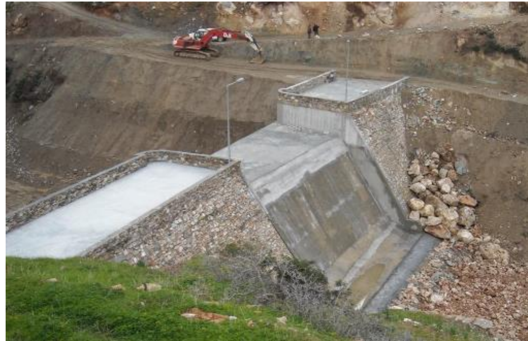
Φράγμα Καμάρες (Σίφνος), εν μέρει λιθόκτιστο
