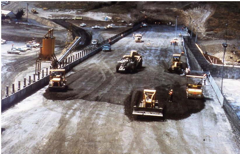
Willow Creek, Όρεγκον (52 m, κατασκευάστηκε σε <5 μήνες, το πρώτο μεγάλο φράγμα εξ ολοκλήρου με RCC)
