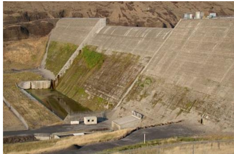
Willow Creek, Όρεγκον (52 m, κατασκευάστηκε σε <5 μήνες, το πρώτο μεγάλο φράγμα εξ ολοκλήρου με RCC)
