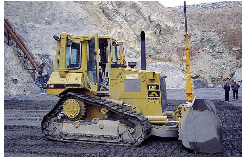
Διάστρωση RCC
