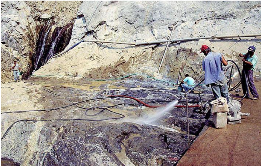
Καθαρισμός θεμελίωσης με νερό και πεπιεσμένο αέρα
