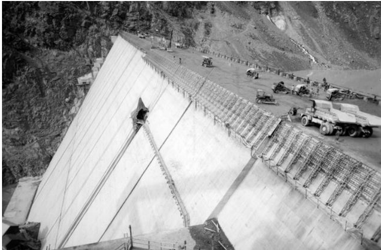
Alpe Gera, Ιταλία (1964, ύψος 174 m, θεωρείται ως ο πρόδρομος των φραγμάτων RCC)
