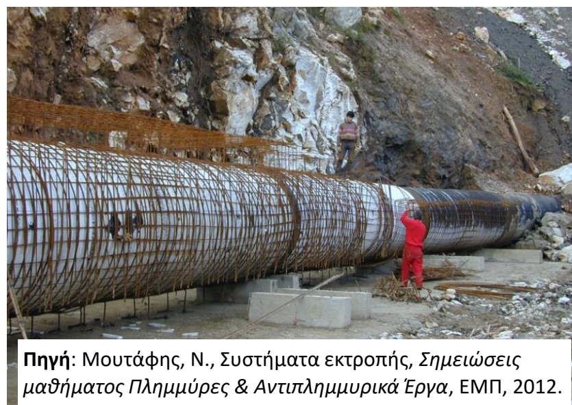
Διέλευση κάτω από την πλίνθο (όπου εδράζεται η ανάντη πλάκα σκυροδέματος)
