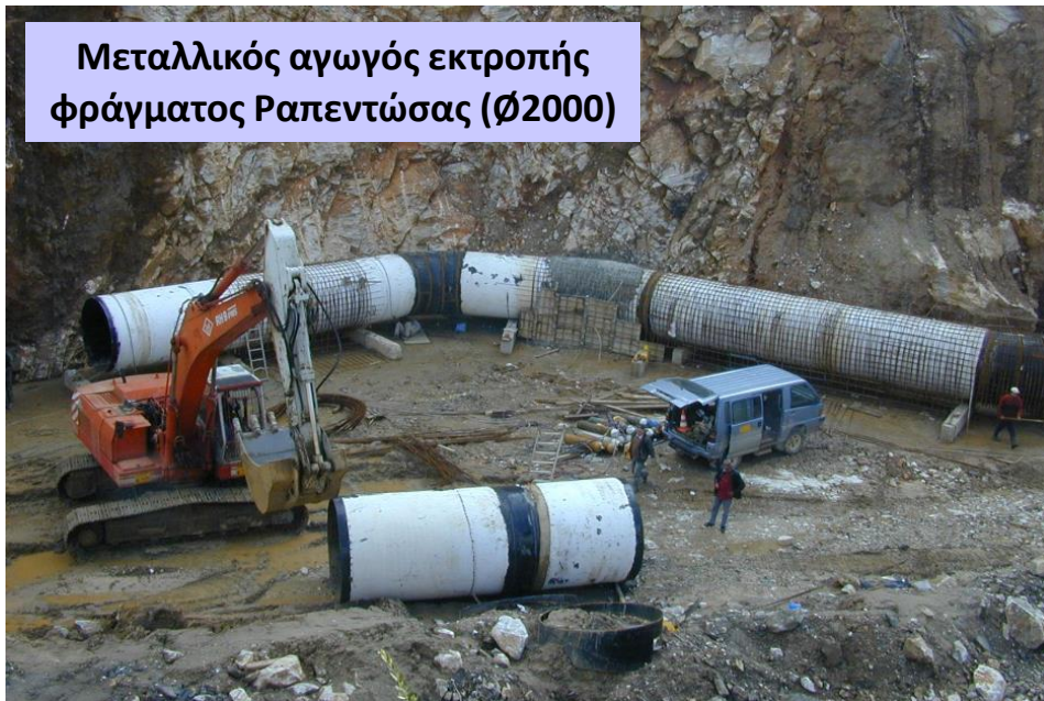
Επένδυση αγωγού με οπλισμένο σκυρόδεμα
