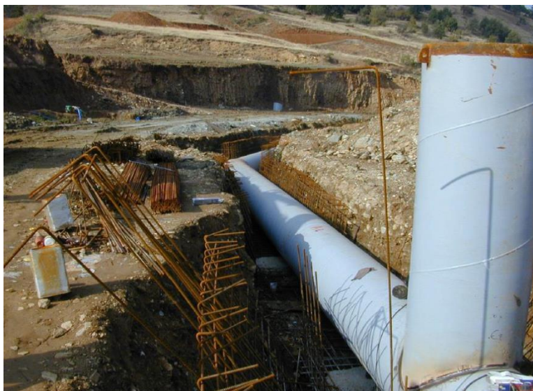
Αγωγός εκτροπής φράγματος Μυλοποτάμου
