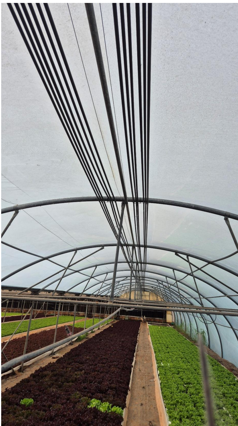
Εικόνα 39 Θερμοκηπιακή εφαρμογή θέρμανσης νερού με σωλήνες PVC, τοποθετημένους στον κορφιά της κατασκευής για μεγιστοποίηση της απορρόφησης ηλιακής ενέργειας (μονάδα Markatos Hydroponics).
