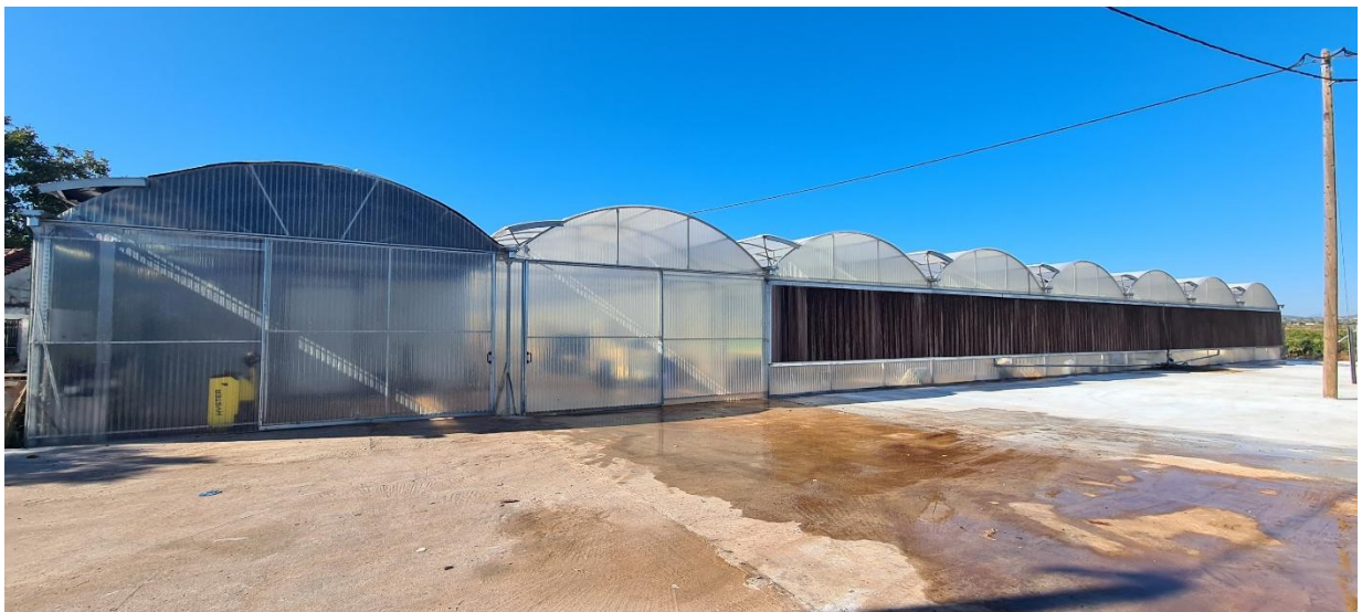
Εικόνα 13 Πανοραμική εξωτερική όψη μέρους των θερμοκηπίων της μονάδας Markatos Hydroponics.
