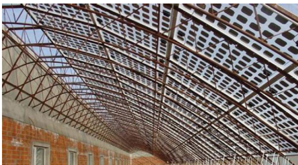
Εικόνα 36 Εφαρμογή ημιδιαφανών φωτοβολταϊκών πάνελ στην οροφή θερμοκηπίου, για ταυτόχρονη παραγωγή ενέργειας και ρύθμιση της ηλιακής ακτινοβολίας [178].
