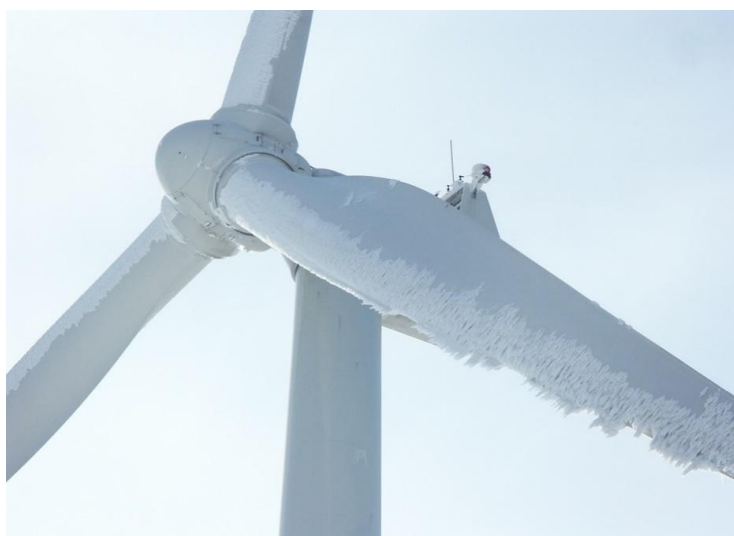
Εικόνα 2: Εμφάνιση πάγου στα πτερύγια της ανεμογεννήτριας (Πηγή: Icwind )
