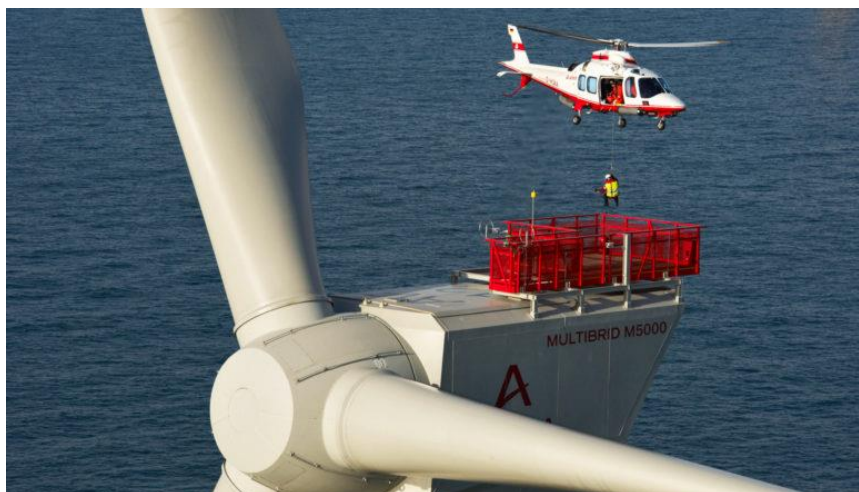
Εικόνα 18: Εργασίες συντήρησης υπεράκτιας ανεμογεννήτριας με εναέρια πρόσβαση (Πηγή: Offshore wind innovation )
