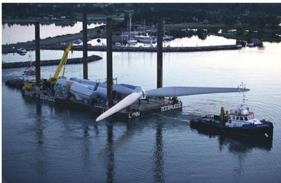
Εικόνα 14: Μεταφορά ρότορα διαμέτρου 70 m στο ΥΑΠ Yttre Stengrund της Σουηδίας
