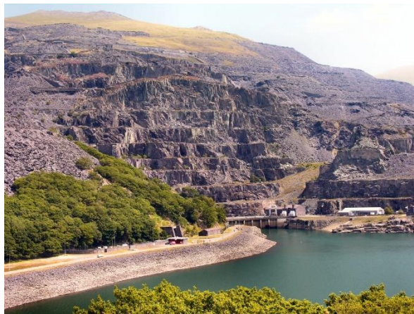
Εικόνα 2.3 Το Dinorwig Power Station, γνωστό και ως Electric Mountain. Πηγή: Wikipedia
