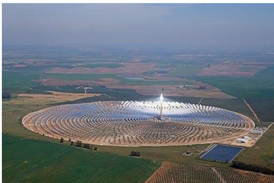
Σχήμα 4.9 Ο ηλιοθερμικός σταθμός συγκεντροτικής ηλιακής ενέργειας Gemasolar με σύστημα αποθήκευσης θερμότητας με τηγμένα άλατα [119].
