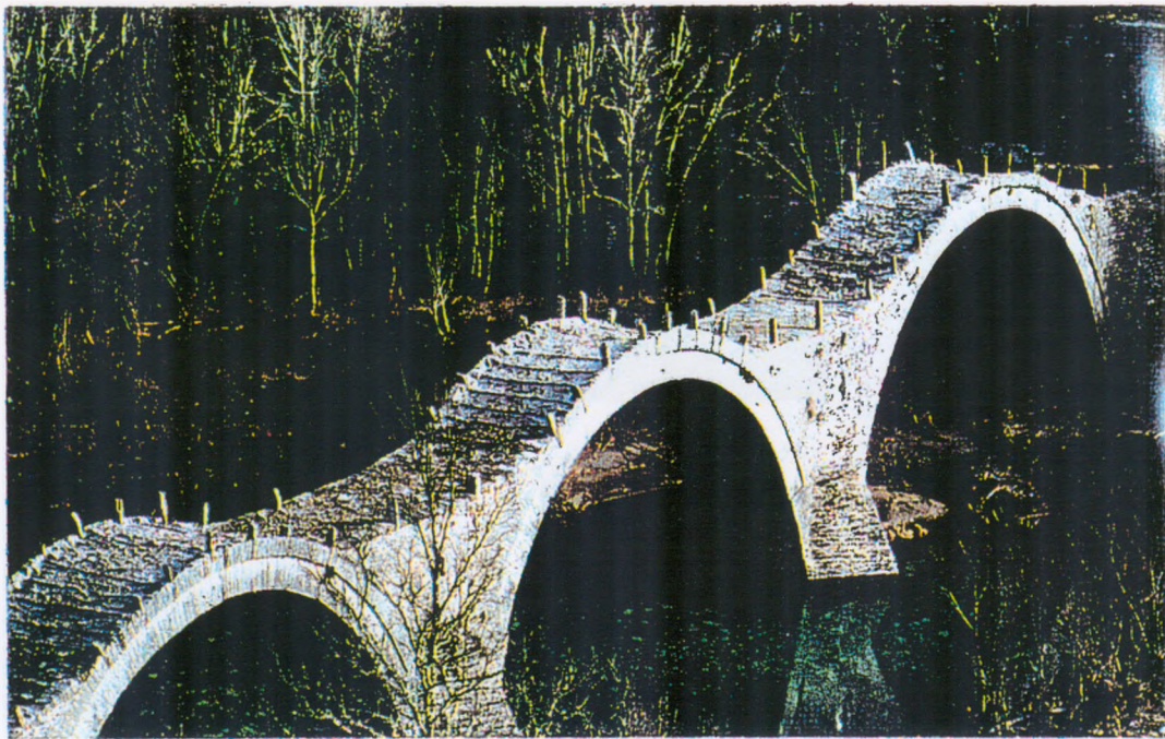
Φωτ 7.1 Τρίτοξο γεφύρι Κήπων
