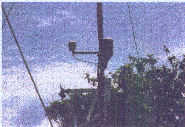
**Σχήμα 3.13** Αισθητήρες μέτρησης θερμοκρασίας, υγρασίας, ταχύτητας και διεύθυνσης του ανέμου στον Α.Μ.Σ. Γραμμενίτσας, σε ύψος 3 m.
