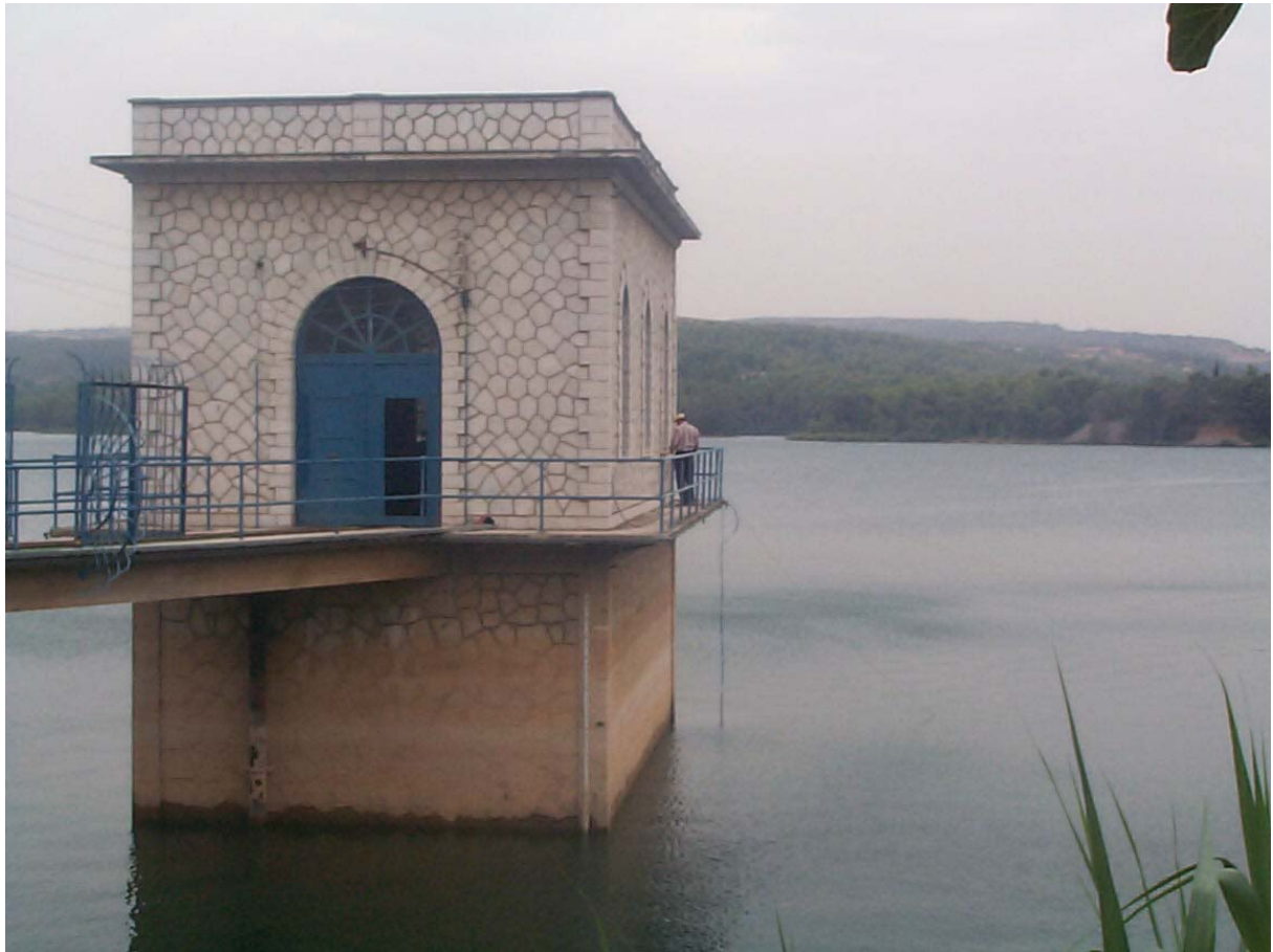
Φωτογραφία 4 Αυτόματος και συμβατικός σταθμημετρικός σταθμός Μαραθώνα
