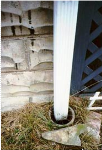
Παράνομη σύνδεση υδροροής στο δίκτυο ακαθάρτων
