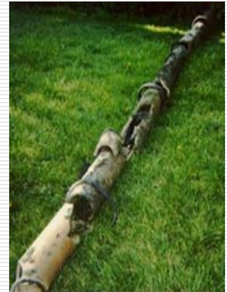
Διαβρωμένος αγωγός αποχέτευσης
