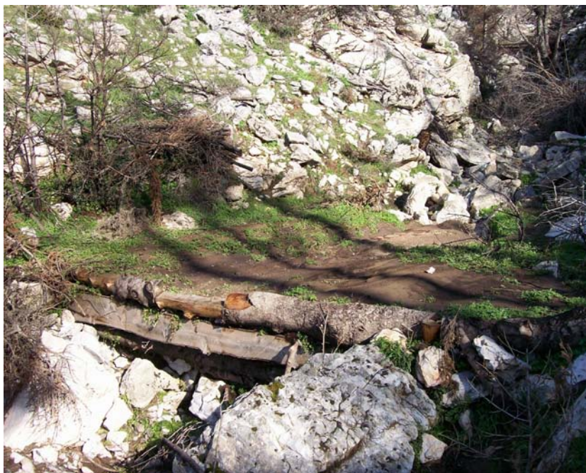
Εικόνα 6.4. Κορμόφραγμα από οριζόντιους κορμούς, στηριγμένους σε βράχους, με υπερχειλιστή (φωτ. από συγγραφείς).
