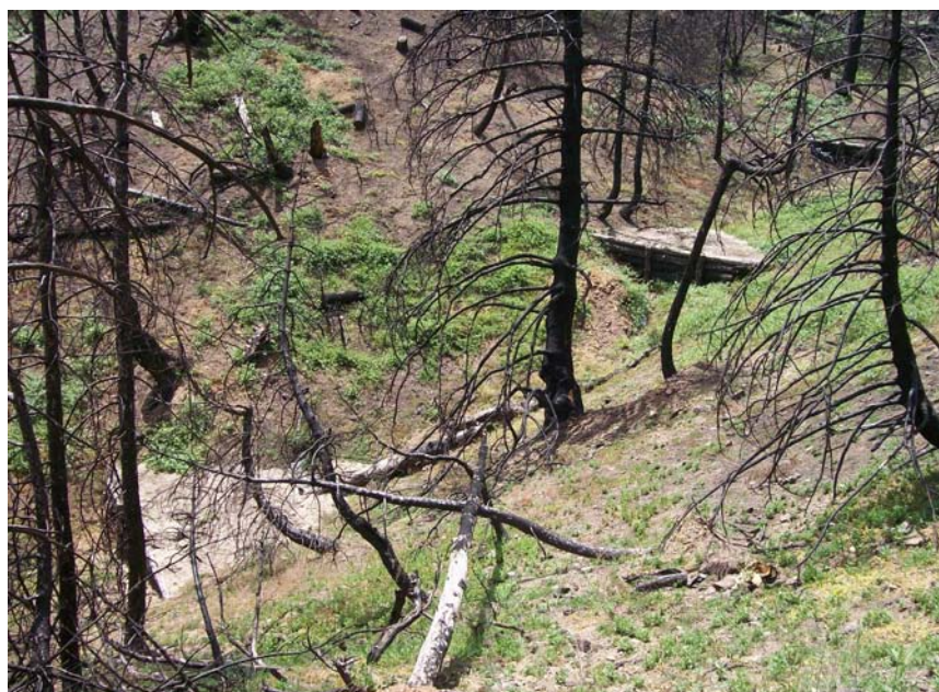
Εικόνα 6.14. Κορμοφράγματα σε σειρά. Αν και έχουν πληρωθεί εντελώς με αμμώδες υλικό που δεν μπορεί να φυτρώσει, παραμένουν φιλικά προς το περιβάλλον (φωτ. από συγγραφείς)
