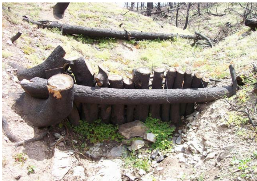
Εικόνα 6.5. Κορμόφραγμα από κατακόρυφους κορμούς, που στηρίζονται σε οριζόντιο και αυτός με τη σειρά του σε πρέμνο από δεξιά (κατά τη ροή) και πάσσαλο από αριστερά (φωτ. από συγγραφείς)
