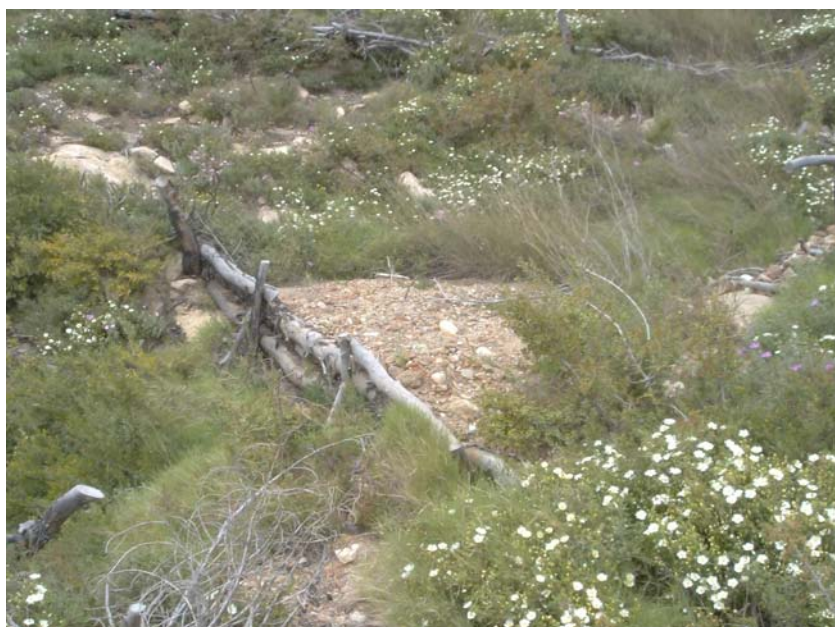
Εικόνα 6.16. Κορμόφραγμα στην Πεντέλη, όπου είναι εμφανές πως το συγκρατούμενο έδαφος δύσκολα φυτρώνει. Ωστόσο, το φράγμα φαίνεται πως δένει με το τοπίο (Ανδρου κ.α. 2007(b))
