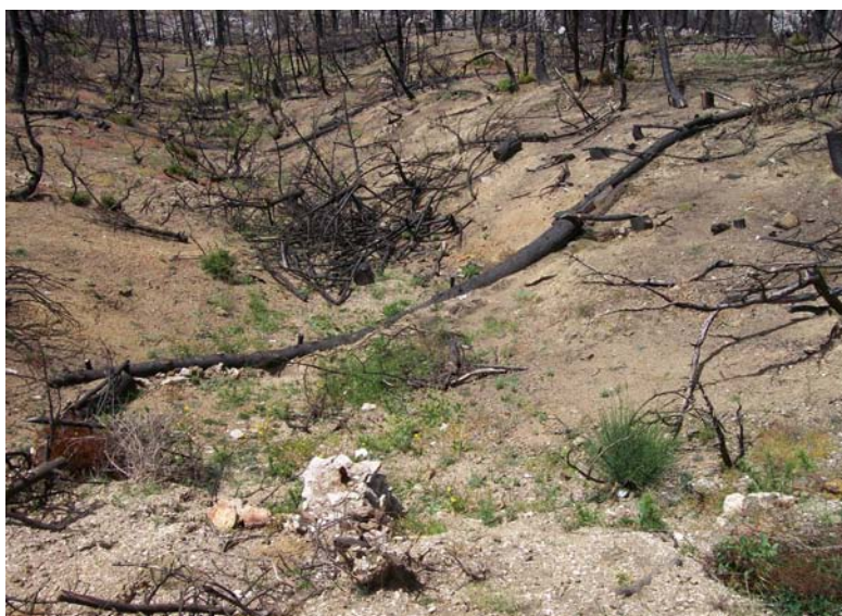
Εικόνα 6.13. Η συνεχόμενη κορμοσειρά δεν έχει κανένα νόημα. Η πλήρωση θα γίνει μόνο στο κοίλωμα (φωτ. από συγγραφείς).
