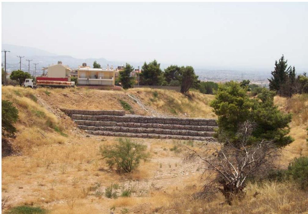
Εικόνα 6.6. Μεγάλο φράγμα από συρματοκιβώτια (το μεγαλύτερο με πλάτος κοίτης πάνω από 10 m) στην έξοδο του ρέματος Χούνης (φωτ. από συγγραφείς).
