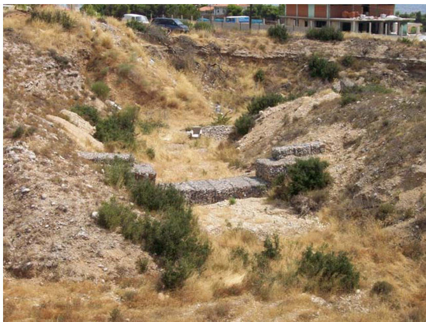
Εικόνα 6.18. Φράγμα από συρματοκιβώτια από τα ανάντη, ακριβώς πάνω από τα πρώτα σπίτια των Θρακομακεδόνων. Έχει συγκρατηθεί σημαντική ποσότητα φερτών χωρίς να πληγώνεται ιδιαίτερα η αισθητική του τοπίου (φωτ. από συγγραφείς).
