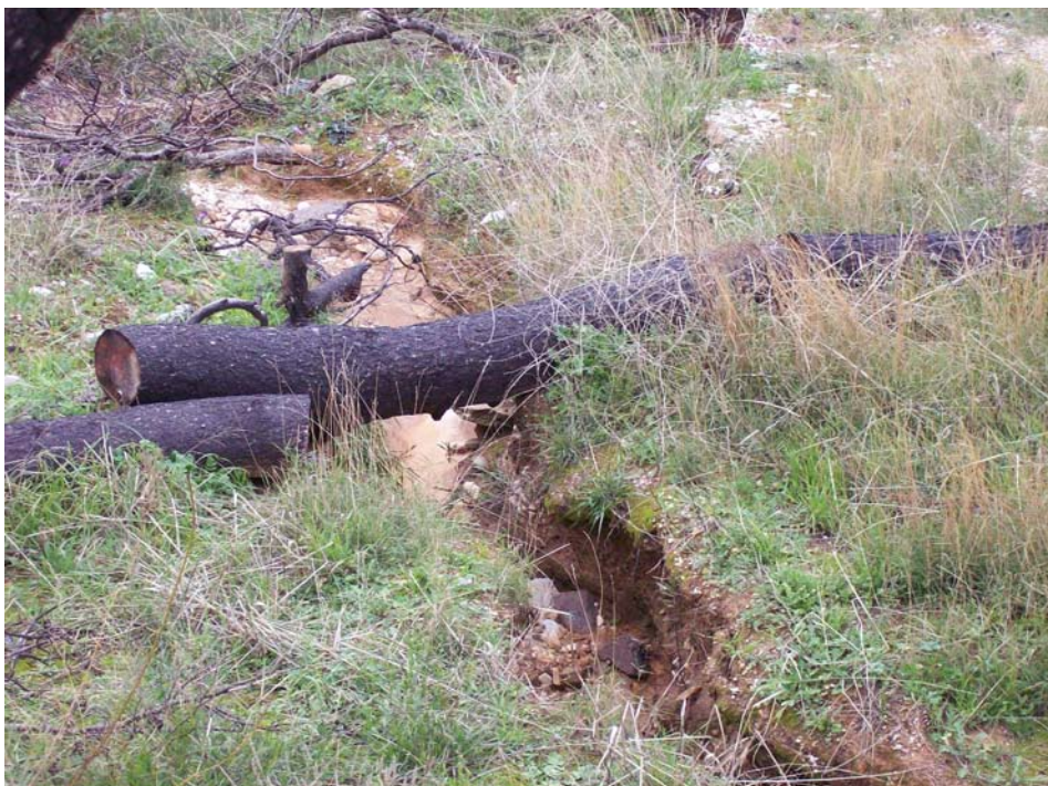
Εικόνα Π4.7. Η κακή συνάφεια κορμοδέματος-εδάφους έφερε σοβαρό πρόβλημα υποσκαφής και αυτό με τη σειρά του σοβαρό πρόβλημα διάβρωσης. Χωρίς το κορμόδεμα πιθανώς να αποφεύγαμε αυτή τη χαραδρωτική διάβρωση (φωτ. από συγγραφείς).
