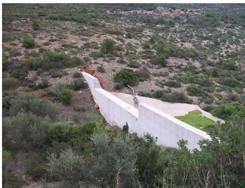
Εικόνα 6.19. Φράγμα από σκυρόδεμα στην Πεντέλη (ρέμα Ραπεντώσας), από ανάντη, με αντιδιαβρωτικό και αντιπλημμυρικό χαρακτήρα. Κατάντη διακρίνεται η λεκάνη αποτόνωσης της ενέργειας. Η συνολική κατασκευή είναι πραγματικά πολύ υπερβολική για τα δεδομένα του τοπίου (φωτ. από συγγραφείς).
