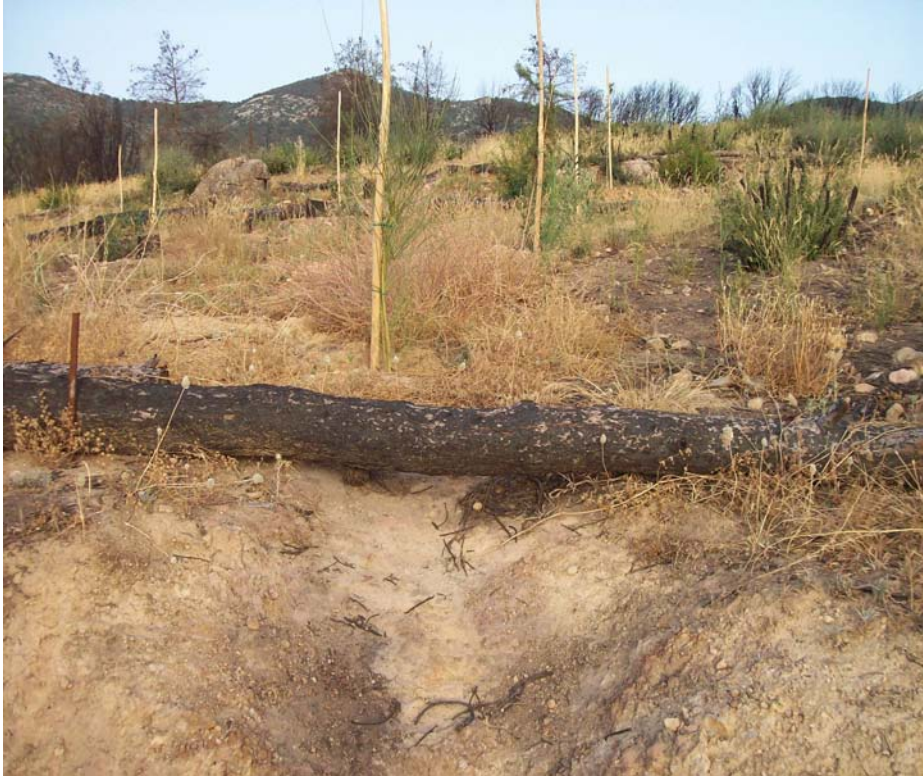
Εικόνα Π4.8. Κορμόδεμα σε πλήρη αστοχία στον Υμηττό. Είναι φανερό πως στα σημεία υποσκαφής συντελείται πολύ ισχυρή διάβρωση (φωτ. από συγγραφείς).
