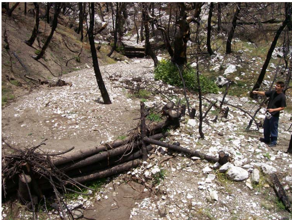
Εικόνα 6.15. Μεγάλα κορμοφράγματα (πλάτος κοίτης περίπου 10 m και υπέργειο ύψος 1,5 m) στο ρέμα Μποντιά της Πάρνηθας, που δένουν καλά με το τοπίο (φωτ. από συγγραφείς).
