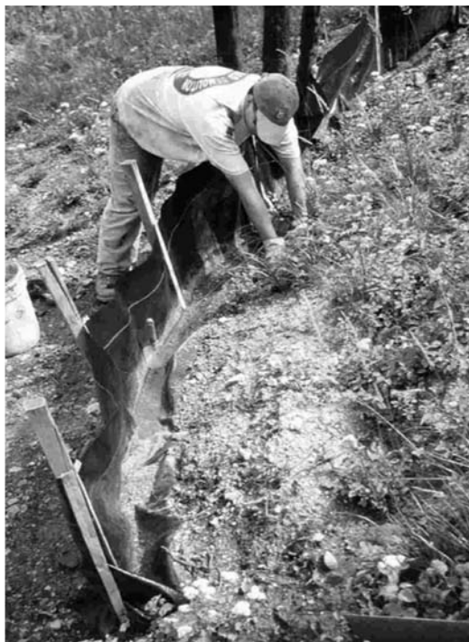
Εικόνα 5.3. Φράκτης φερτών υλικών με γεωφάσμα (Robichaud and Brown, 2002).
