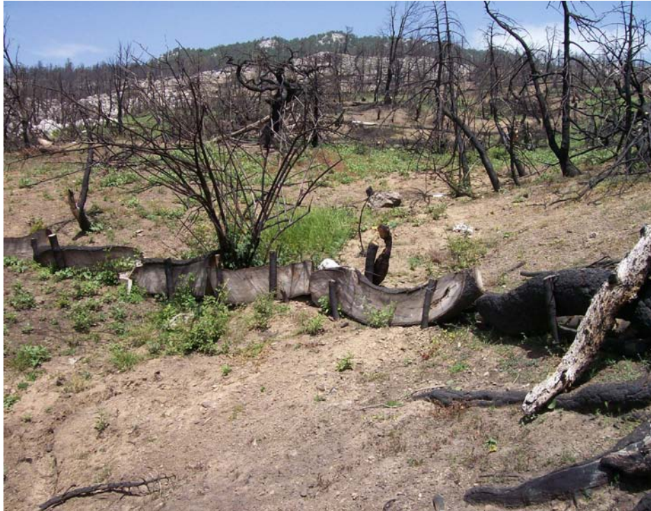
Εικόνα Π4.6. Όταν υπάρχει έλλειψη κορμών, οι κορμοί κόβονται κατά μήκος. Η τεχνική αυτή ίσως να έχει καλύτερα αποτελέσματα καθώς βοηθά στην καλύτερη συνάφεια κορμού-εδάφους (φωτ. από συγγραφείς).
