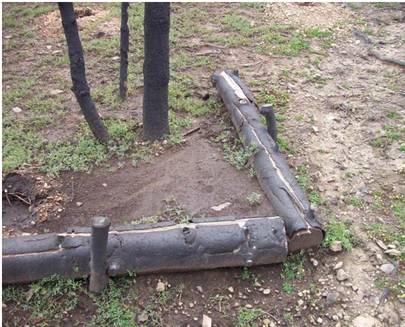
Εικόνα Π4.4. Στο τελείωμα της κορμοσειράς, συνήθως μπαίνει ένας κάθετος κορμός μήκους περίπου 1 m. Η τεχνική αυτή φαίνεται πως αποδίδει. Και εδώ βέβαια φαίνεται πως το έδαφος που συγκρατείται δεν φυτρώνει (φωτ. από συγγραφείς).
