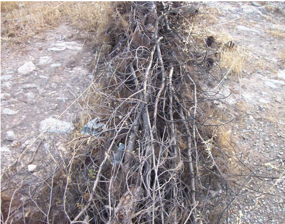
Εικόνα Π4.9. Οι κλαδοσφοροί όχι μόνον είναι πλήρως αναποτελεσματικοί, καθώς δεν υπάρχει καμία συνάφεια μεταξύ των κλάδων και κλάδων-εδάφους, αλλά και επικίνδυνοι καθώς κάνουν την περιοχή πολύ πιο εύφλεκτη (φωτ. από συγγραφείς).
