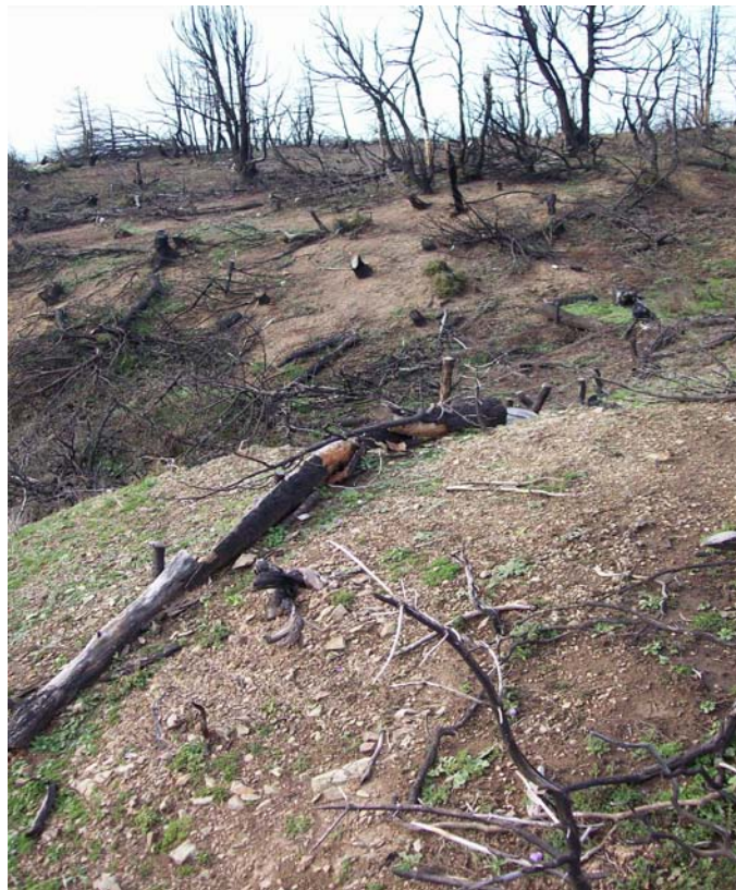
Εικόνα Π4.2. Αστοχία κορμοδέματος καθώς έχει τοποθετηθεί επάνω σε κύρτωση της πλαγιάς. Η τοποθέτηση αυτή δεν έχει κανένα νόημα (φωτ. από συγγραφείς).
