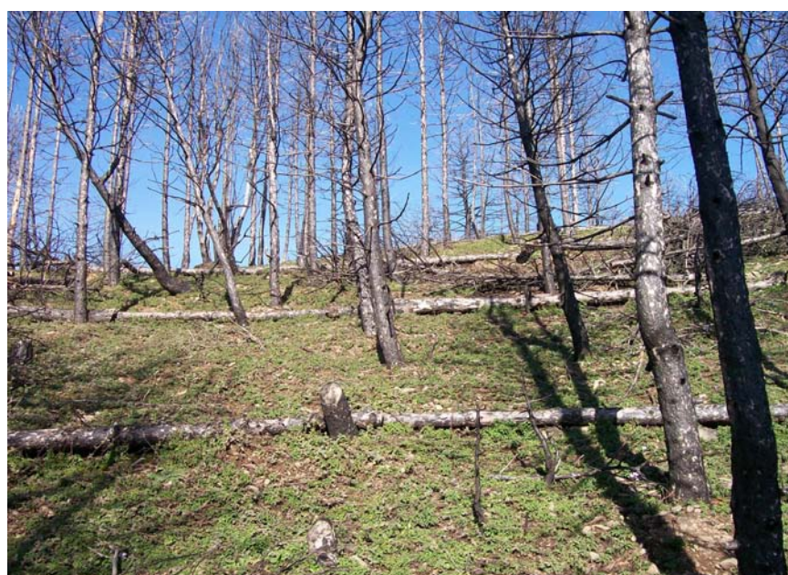
Εικόνα 6.3. Κορμοδέματα με στήριξη στα πρέμνα (φωτ. από συγγραφείς).
