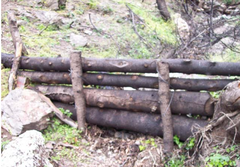
Εικόνα Π4.1. Χαρακτηριστική αστοχία κορμοφράγματος στην Πάρνηθα, λόγω μη καλής συνάφειας των κορμών μεταξύ τους. Οι δυο κατώτεροι κορμοί που “ακουμπάνε” καλύτερα μεταξύ τους έχουν συγκρατήσει κάποια ποσότητα φερτών (φωτ. από συγγραφείς).
