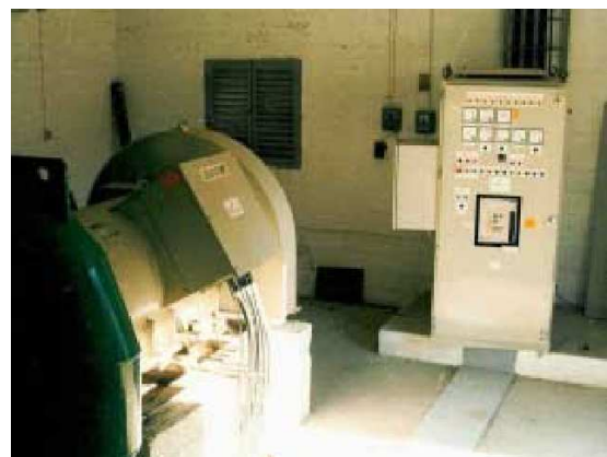
Εικόνα 4.2: Εσωτερικό Μηχανοστασίου Μ.Υ.Η.Ε.
