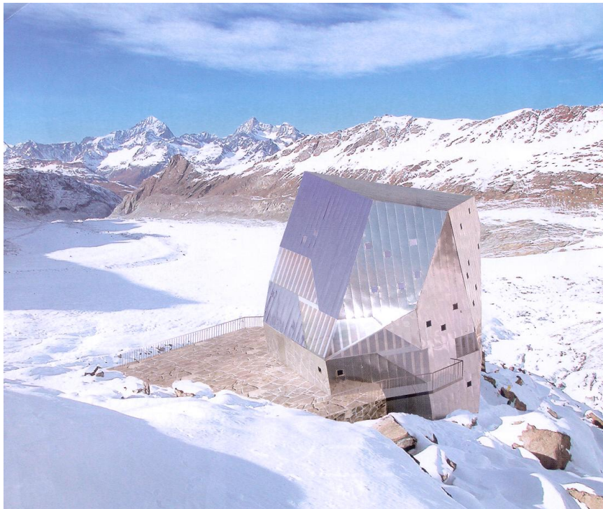
Εικόνα 3.1 : Καταφύγιο νέας λογικής, σε υψόμετρο 2.883 μέτρων, στην περιοχή Monte Rosa του Καντονιού του Valais, με ένα Φ/Β σύστημα 85 μ 2 και θερμικούς ηλιακούς συλλέκτες 35 μ 2
