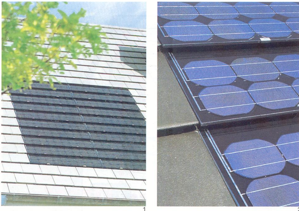
Σχήμα 3.3 : 1. Φ/Β πανό ενσωματωμένα σε στέγη σε αντικατάσταση των πλακών επικάλυψης. 2. Λεπτομέρεια τοποθέτησης Φ/Β πανό. (πηγή :τεχνικό περιοδικό ΚΤΙΡΙΟ-Οκτώβριος 2000)
