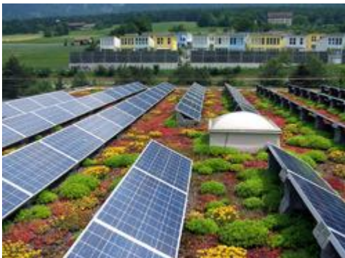
Σχήμα 8.6 : Συνδυασμός Φ/Β με πράσινη στέγη
